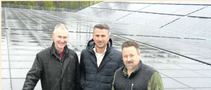
Das neue Solarkraftwerk auf der Deponie Tambrig in Obfelden konnte besichtigt werden.
