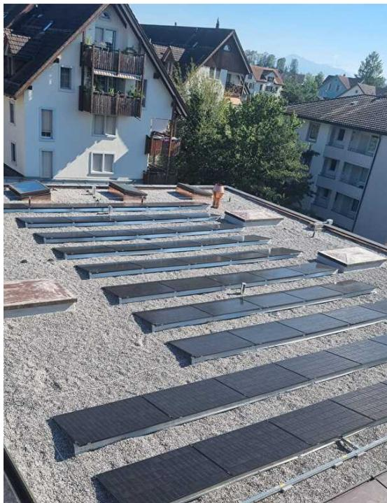
Die PV-Anlage auf dem Stadthaus Affoltern hat eine Leistung von 42 KW -Peak und trug auch zur Erfüllung des Energiestadt-Ziels bei.
