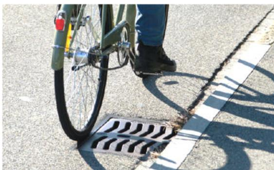
Eines der Ziele ist es, die Sicherheit zu erhöhen. — Eine Gefahr beim Ausweichen nach Rechts sind für Fahrräder mit schmalen Pneus, namentlich Rennräder, längs gestreifte Dolendeckel (Bild: Bernhard Schneider).
