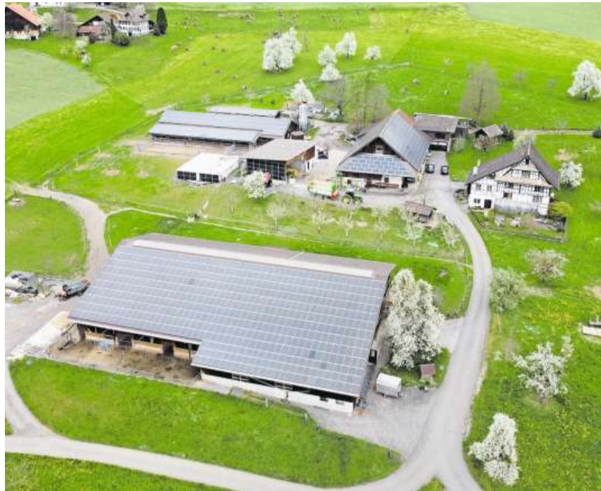
Der Biohof Wesenmatt in Hausen zeigt seine Klein-Biogasanlage. (Bild zvg)
