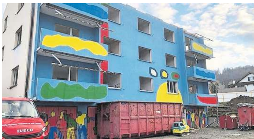
Im neuen Kleid vor dem Abbruch: Block an der Albis-/Niederfeldstrasse. (Bild bro)
