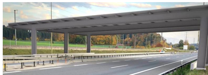
Bildmontage zeigt kurzen Ausschnitt des Solardachs
