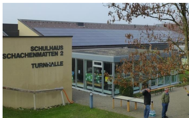
Von Einwohnern finanzierte Solaranlage auf dem Schulhaus Schachenmatten in Bonstetten
